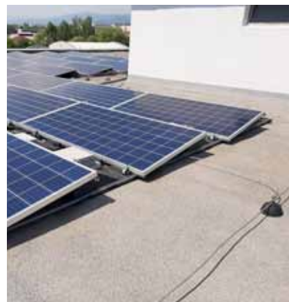
Přitižená konstrukce FVE pomocí betonových prvků
