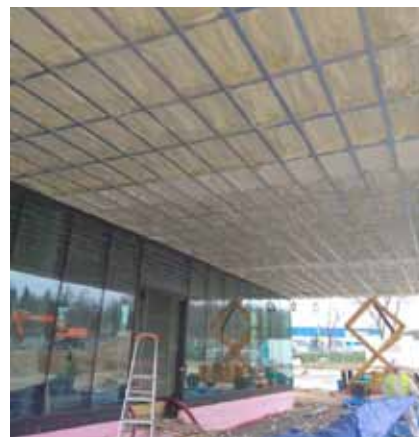
Zateplení podhledu betonového stropu
