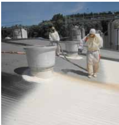
Nástřik izolace střechy živočišné výroby (hliníkový plech)
