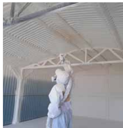
Zaizolování ocelové garáže proti kondenzaci
