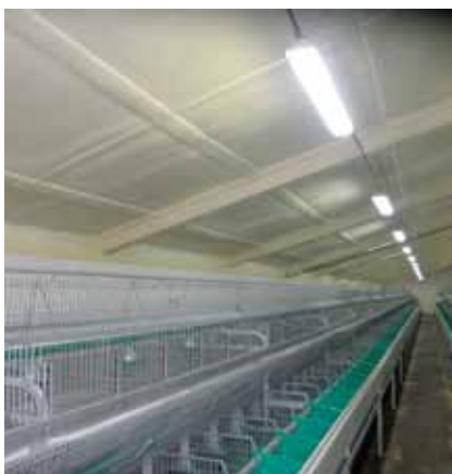
Izolace stropní konstrukce na odchovu králíků
