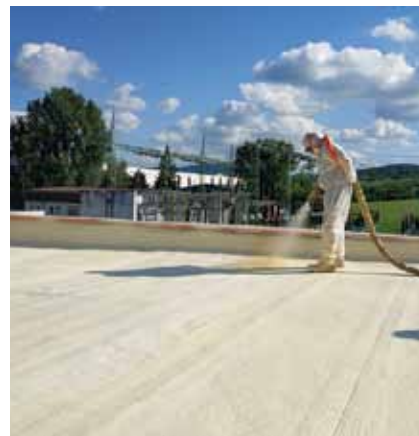
Nástřik izolace střechy průmyslové haly (asfaltové pásy)
