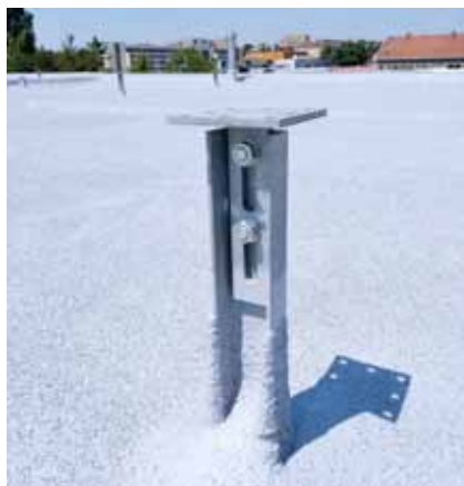
Finální řešení kritického detailu nosné patky
