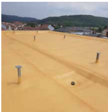
Střecha po nástřiku pénou PUR
