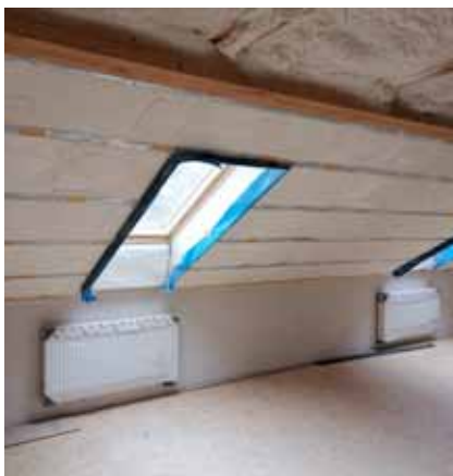
Nástřik podkroví na kontaktní difúzní vrstvu
