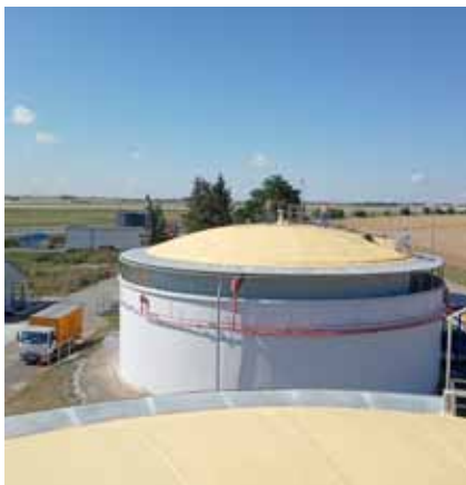
Aplikace izolace na skladovací nádrži (ocelový plech)
