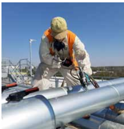
Izolace potrubí - litím PUR pěny „plnicími otvory“
