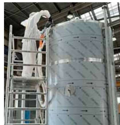
Izolace nádrže – litím PUR pěny „plnicími otvory“
