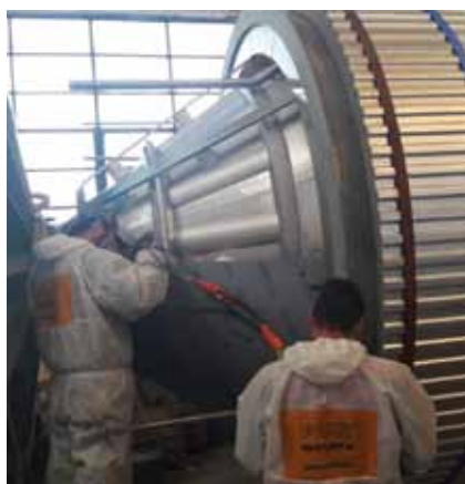
Detail izolace kónusu CKT tanku na pivo
