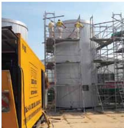
Provádění izolace tanku na pivo
