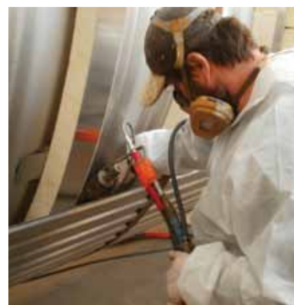
Detail provádění izolace nádrže – lití PUR pěny „za oplechování“
