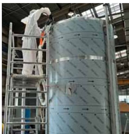
Izolace nádrže – lití PUR pěny „plnicími otvory“
