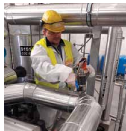
Izolace potrubí – litím PUR pěny „plnicími otvory“
