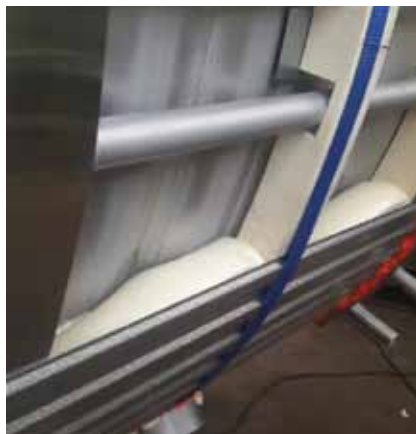
Detail izolace – lití PUR pěny „za oplechování“
