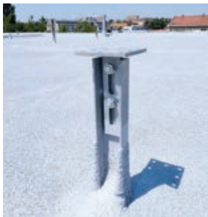
Finální řešení kritického detailu nosné patky
