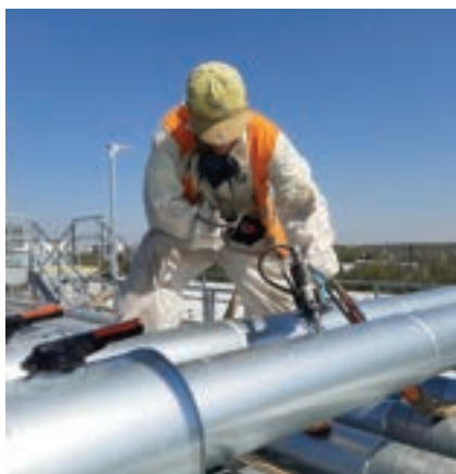
Izolace potrubí - litím PUR pěny „plnicími otvory“
