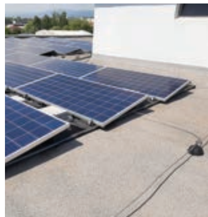
Přitižená konstrukce FVE pomocí betonových prvků
