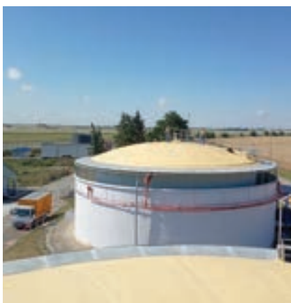
Aplikace izolace na skladovací nádrži (ocelový plech)
