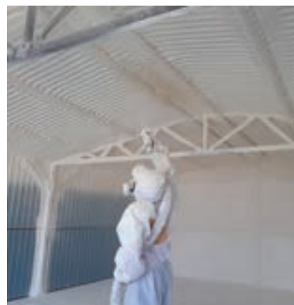
Zaizolování ocelové garáže proti kondenzaci
