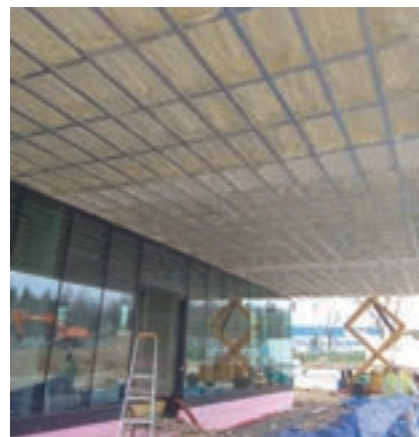
Zateplení podhledu betonového stropu
