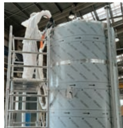
Izolace nádrže - litím PUR pěny „plnicími otvory“
