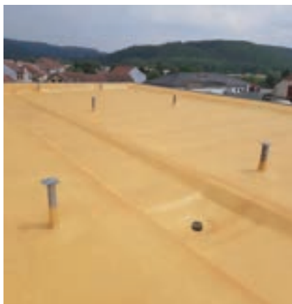
Střecha po nástřiku pénou PUR
