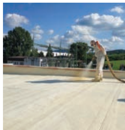
Nástřik izolace střechy průmyslové haly (asfaltové pásy)
