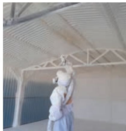
Zaizolování ocelové garáže proti kondenzaci
