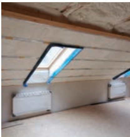
Nástřik podkroví na kontaktní difúzní vrstvu
