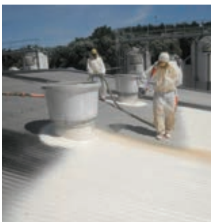
Nástřik izolace střechy živočišné výroby (hliníkový plech)
