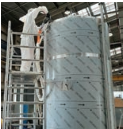
Izolace nádrže - lití PUR pěny „plnicími otvory“
