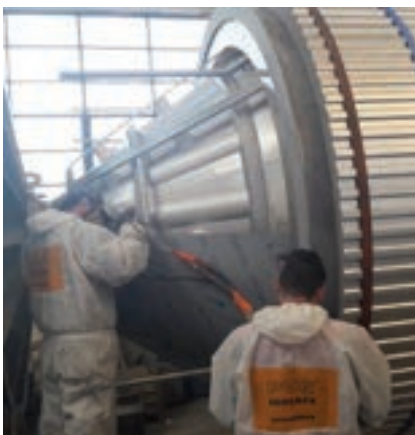
Detail izolace kónusu CKT tanku na pivo
