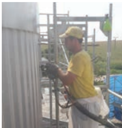
Detail provádění izolace nádrže – lití PUR pěny „plnicími otvory“
