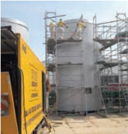
Provádění izolace tanku na pivo
