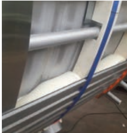
Detail izolace – lití PUR pěny „za oplechování“
