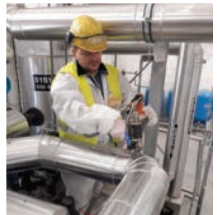
Izolace potrubí – litím PUR pěny „plnicími otvory“
