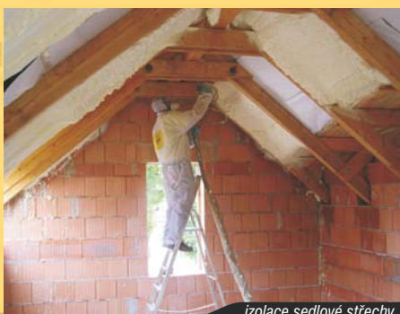
izolace sedlové střechy
