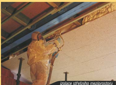
izolace střešního meziprostoru
