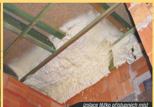
izolace těžko přístupných míst
