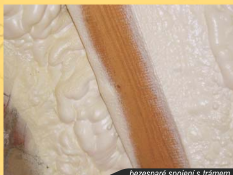
bezparé spojení s trámem
