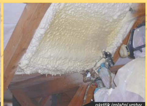
nástřik izolační vrstvy
