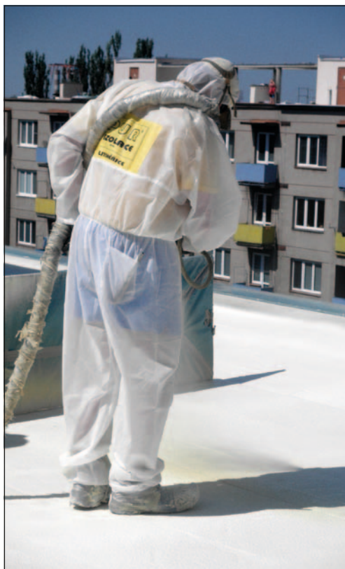
Nástřik tvrdé pěny na ploché střeše je nejsložitějším typem zpracování tvrdých pěn.
