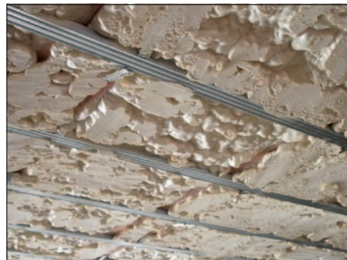
'Hloupe' provedený nástřik 'chytře pěny' - celkový pohled
