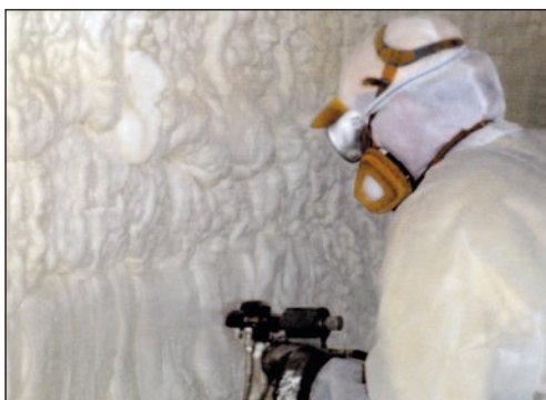
Pracovník PUR Izolace při první aplikaci kanadské pěny Icnene ve Slavkově u Brna.
